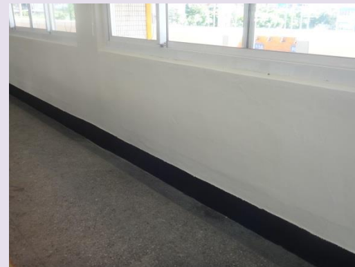
牆面天花板 重新粉刷 ▶
